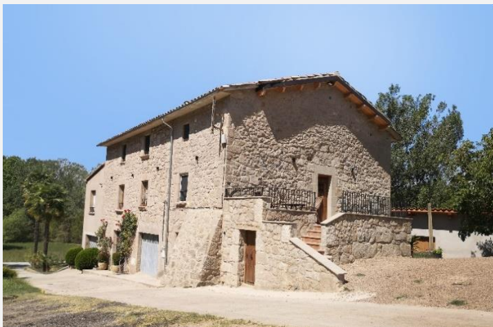
Antiga casa de cal Ferrer, propietat dels Puigferrat, anomenada així des que s'hi van establir, fent de ferrers i, més tard, fent de rellotgers, fins que van marxar a Gironella. Els nous llogaters hi van muntar una farga i va passar a ser coneguda com a cal Fargues, encara avui es poden veure alguns vestigis exteriors per on s'esmunyia l'aigua. (Foto Xavier Cortada).
